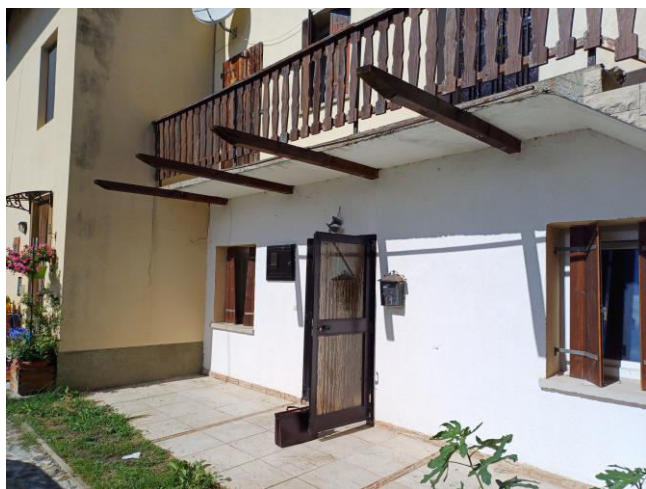
Facciata verso corte
