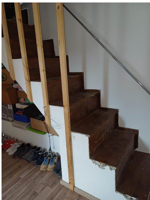
Particolare scala (alzata cm. 25)
