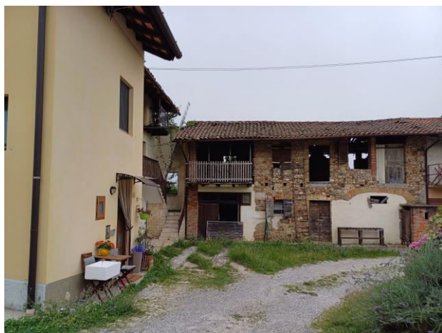
Vista facciata rustico annesso
