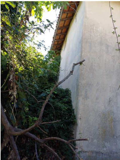
Facciata posteriore del corpo principale
