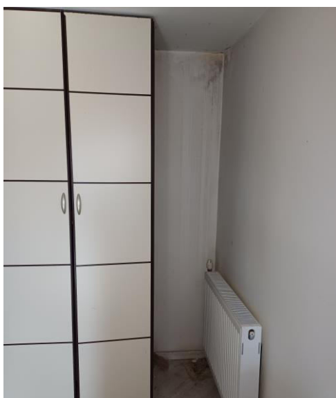
Stanza da letto al primo piano (muffa sulla parete)
