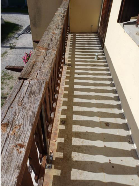
Terrazza primo piano corpo principale
